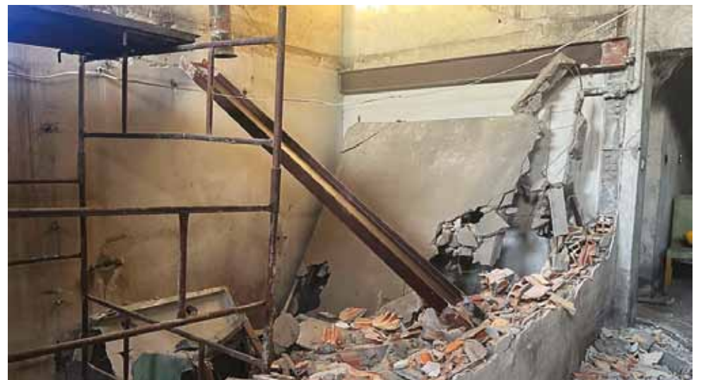
Stara kotłownia zmieni się w nowoczesną przestrzeń dla mieszkańców
